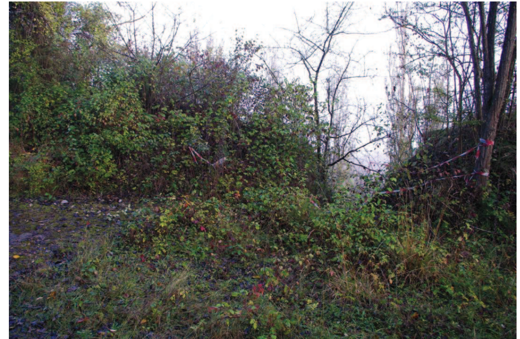
Photo 4 : Absence de merlon le long du quai de jetée de la photo précédente.
