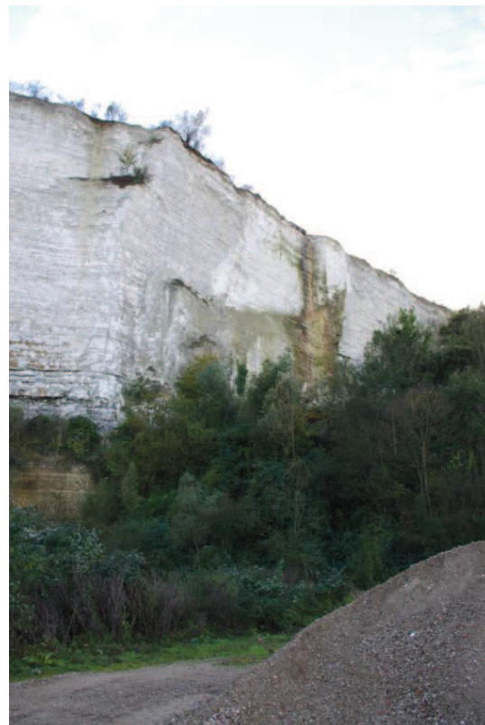
Photo 9 : Vue de l'écaille rocheuse éboulée le 20/12/2012 (Photo INERIS prise en novembre 2014)
